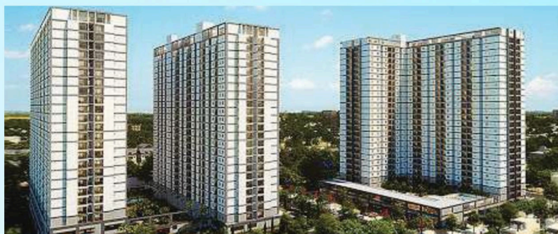
CHUNG CƯ BỘ CÔNG AN BLOCK A - B & C P. AN KHÁNH - TP. HCM
